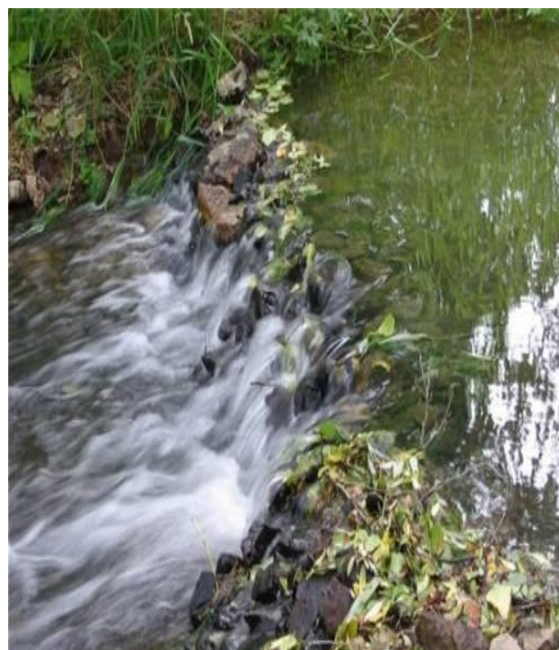
Даже с помощью такой плотины из камней можно поднять уровень воды на метр и более. Фото с сайта: http://rg.foto.radikal.ru/0707/74/f5739a86bbdb.jpg
